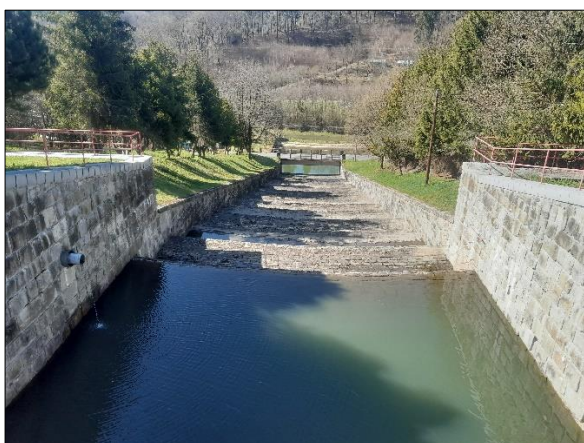
Horní a spodní bazén skluzu VD Bystřička je trvale zvodněn.
